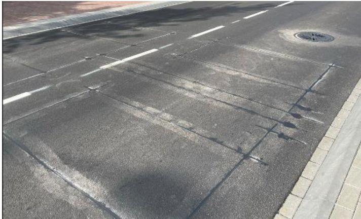
Figuur 2 - elementen in het wegdek ter hoogte van Tongerseweg 237
