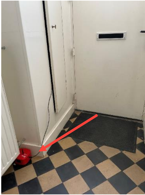
Figuur 3 – meetopstelling schade entree
