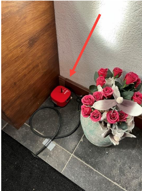
Figuur 4 – meetopstelling schade entree
