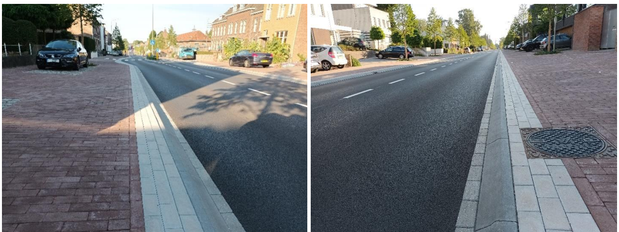
Figuur 2 - situatie wegdek na reconstructiewerkzaamheden, links richting België en rechts richting Maastricht
